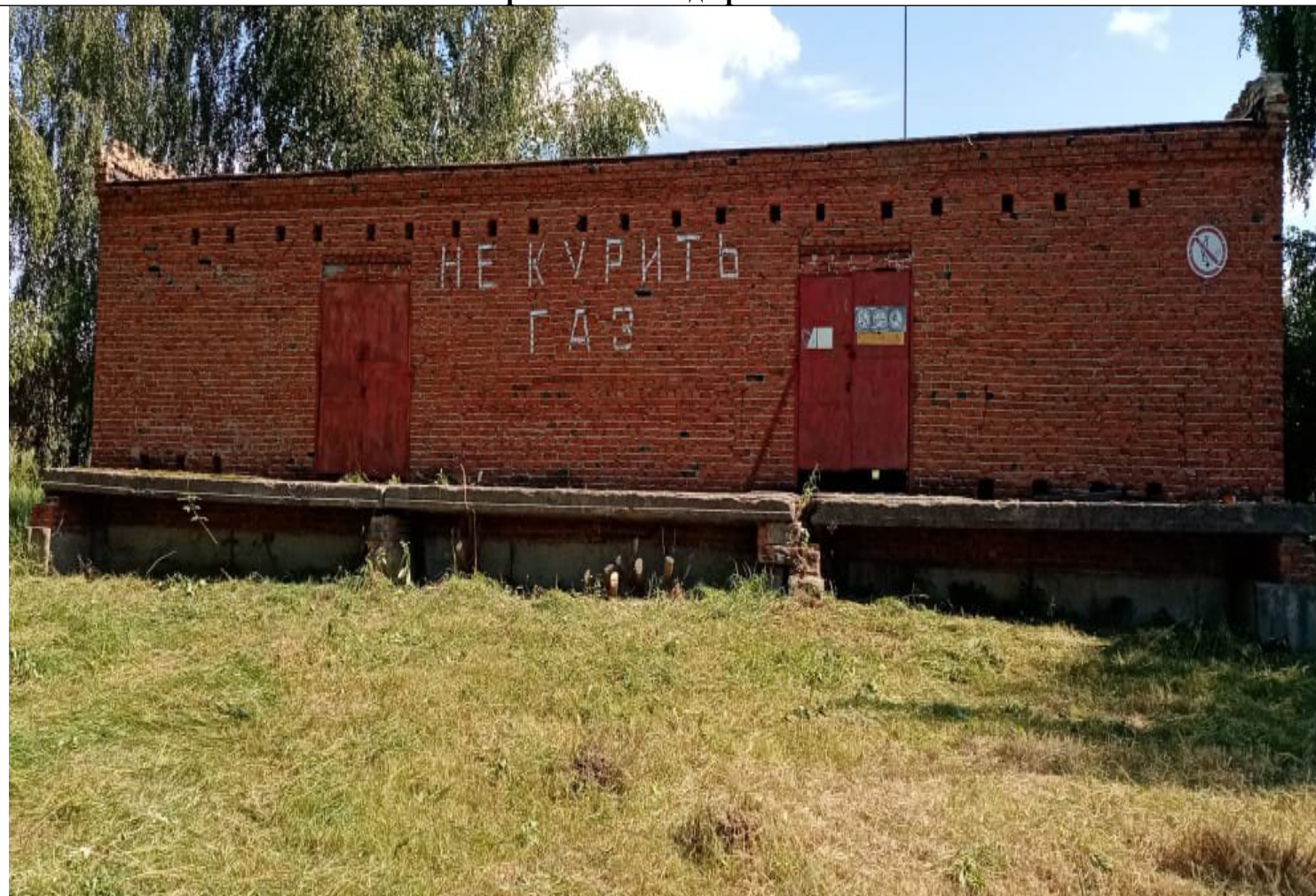
Нежилое строение – Склад хранения баллонов
