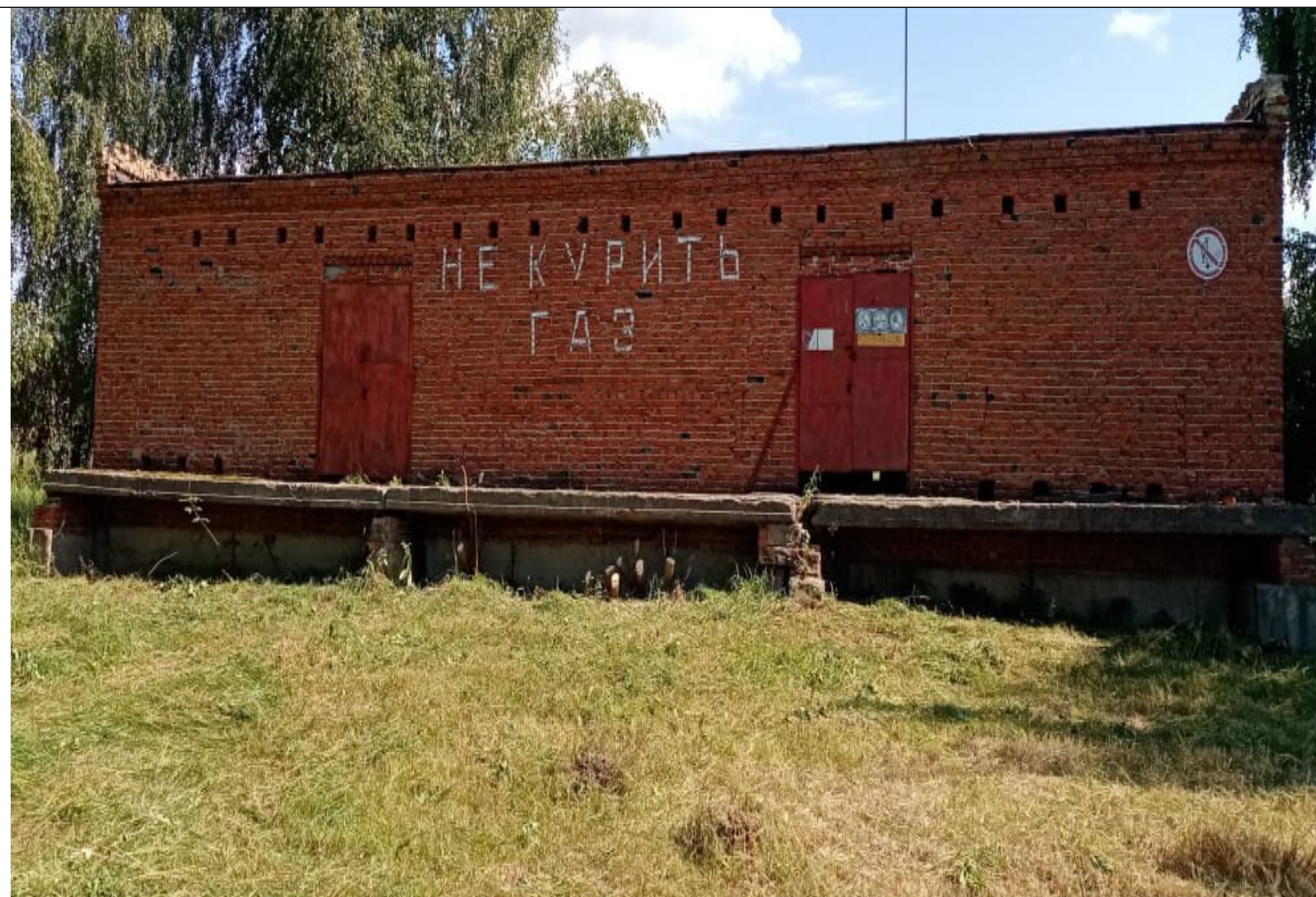
Нежилое строение – Склад хранения баллонов
