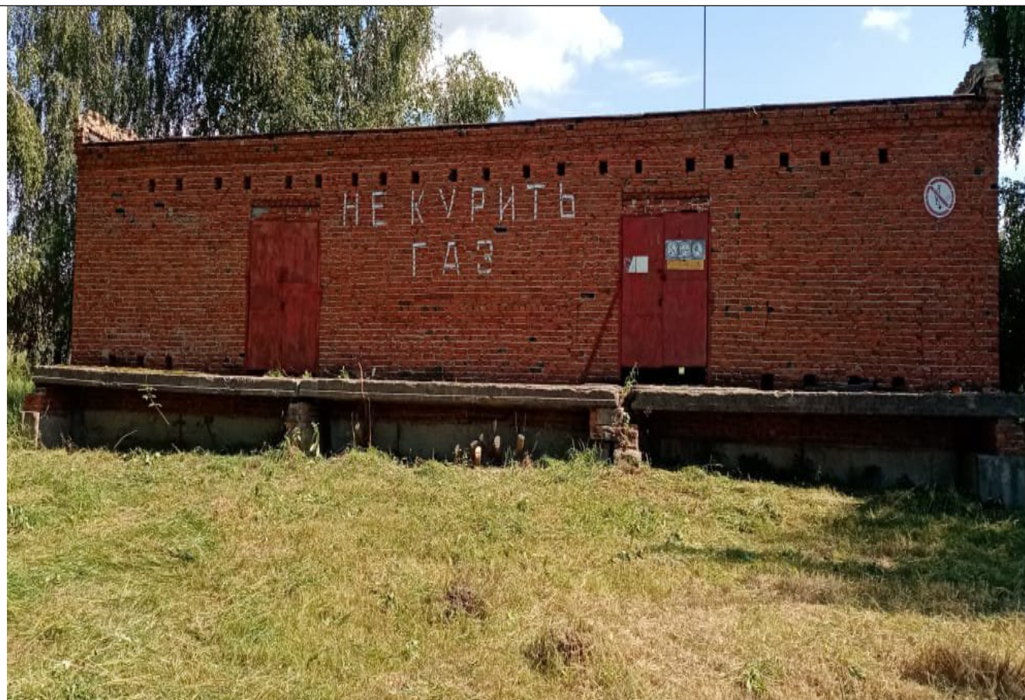
Нежилое строение – Склад хранения баллонов
